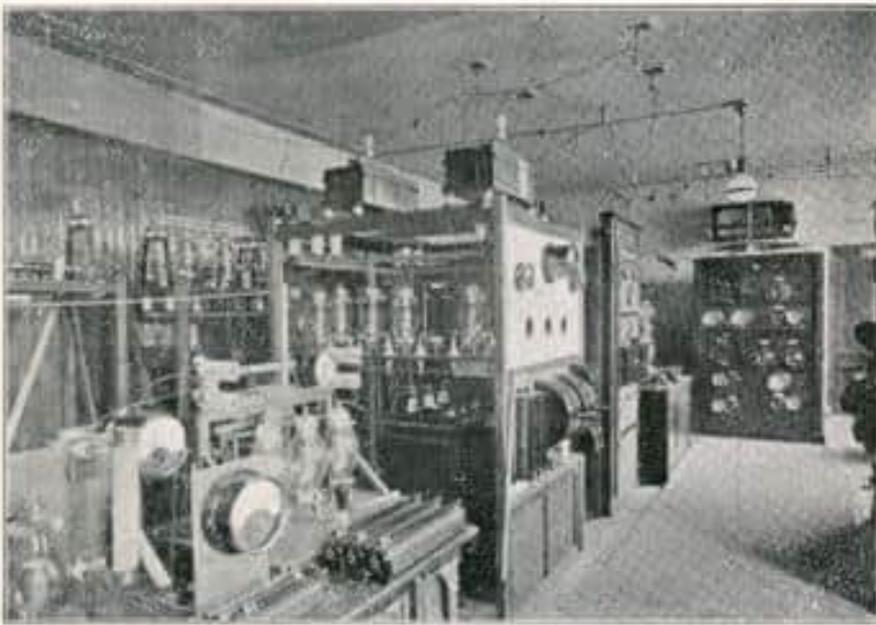
Radiostation te Scheveningen-Haven (Pch.). Vooraan 1\frac{1}{2} K.W.-zender (P.C.Y.Y.); daarnaast de 15-lamps gelijkrichter van de 5 K.W.; daarop volgt de geheele 5 K.W.-zender.
